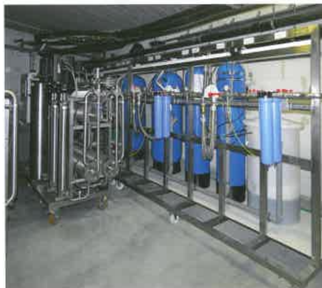
De keuze viel op een voorbehandelingsysteem uitgerust met een kwaliteitsgestuurde waterontharder met meetsondes, een actieve koolfilter en fijnfiltratie, telkens dubbel uitgevoerd.
