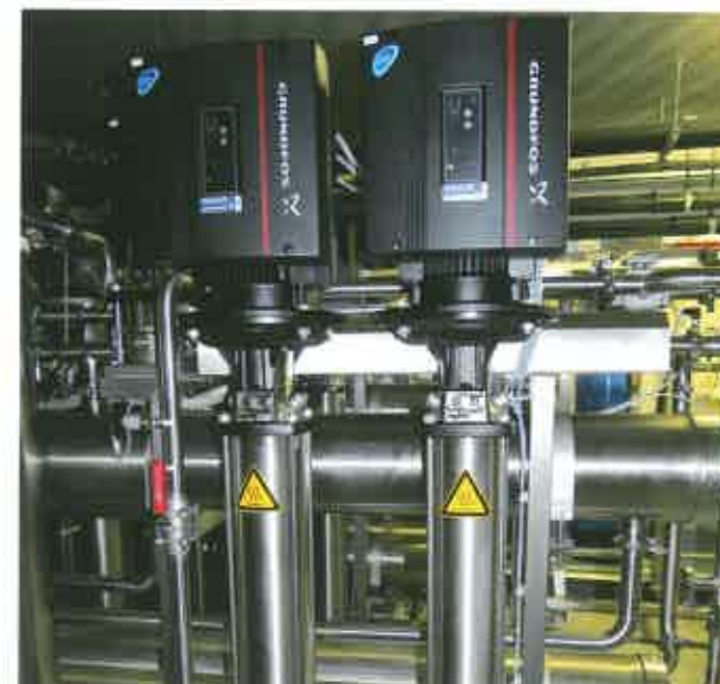
De RO-installatie maakt via reversed osmose mineraalvrij water.
