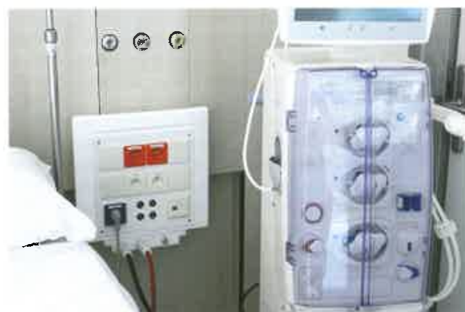
Naast de nippels vind je op het paneel elektriciteits- en netwerkvoorzieningen en een nurse call (oproepsysteem), ingebouwd op maat en kleur van de klant UZA.
